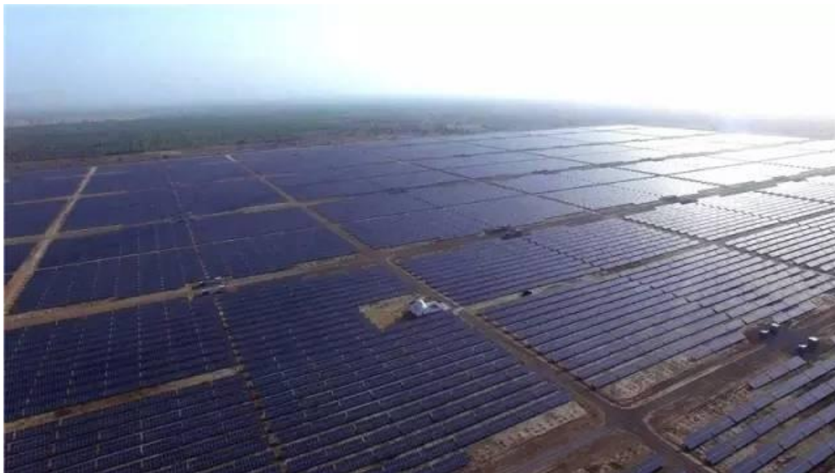
中兴能源巴基斯坦 300 兆瓦光伏电站航拍实景图
