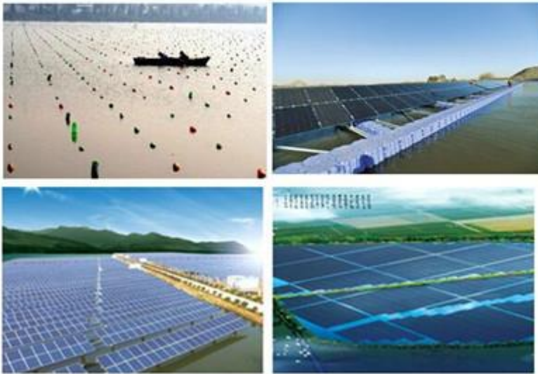
图1 组件安装面平坦，朝向一致
