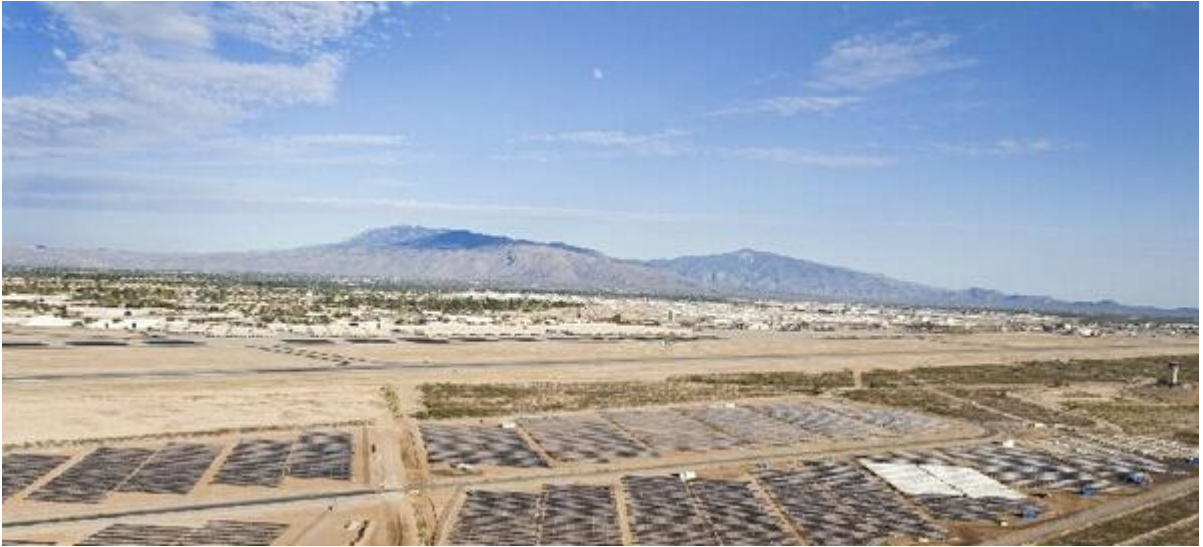
图 2: 在亚利桑那州的空军基地建设的 16.4MW 光伏电站
