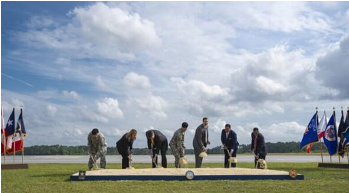
图 3：在乔治亚州斯图尔特堡陆军基地建设的 30MW 光伏电站的开工仪式
