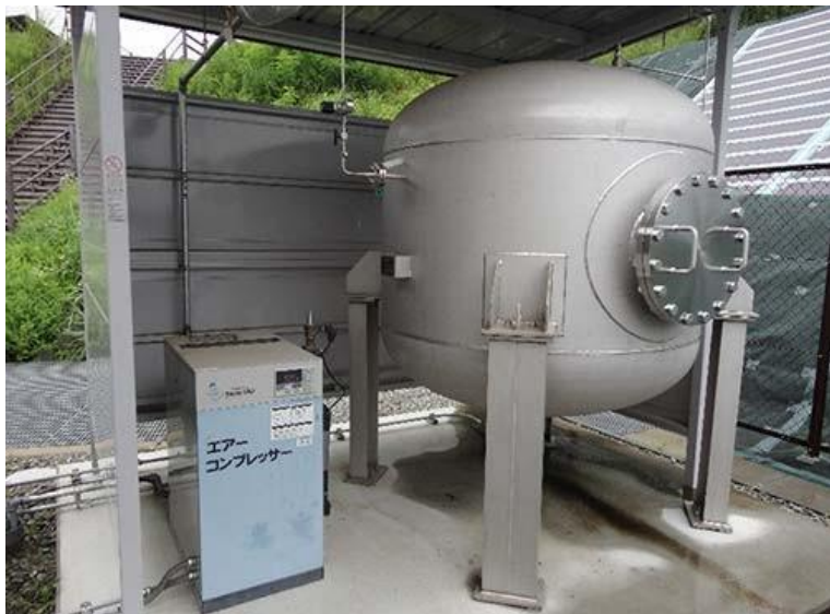
图 7：馆外设置的氢燃料罐
