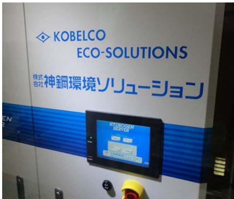
图 3：神钢环境舒立净制造的 PEM 型水电解制氢装置 利用剩余电力制氢
