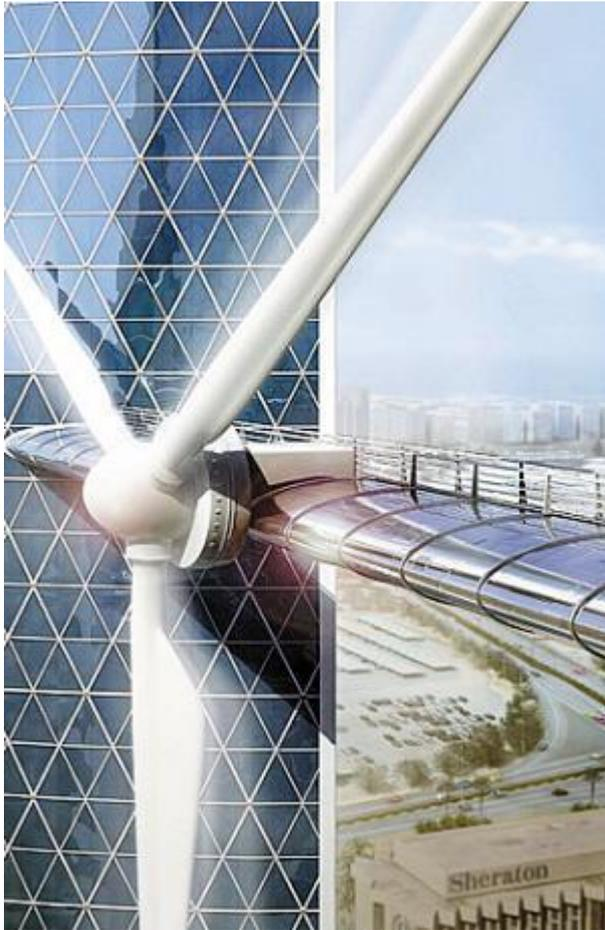
资料显示，这三台发电风车满负荷时的转子速度为每分钟 38 转，通过安置在引擎舱的一系列变速箱，让发电机可以每分钟 1500 转的转速运行发电。在风力强劲，或需要转入停顿状态时，翼片的顶端便会向外推出，增加转子的总力矩，从而达到减速的目的。这三座风机能承受的最大风速是 80 米/秒，且可经受住 4 级飓风(风速每秒 69 米以上)。
