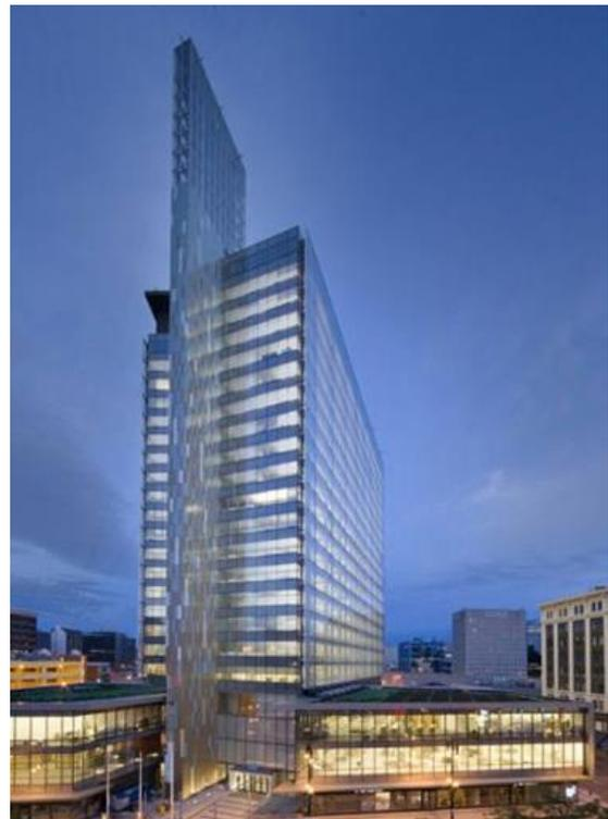
肺一样吸纳进新鲜的户外空气，并送到工作场所。每一座中庭都设置了瀑布，根据季节加湿或干燥空气。高达 377 英尺高的呈“热烟囱”形状的主楼坐落于主入口，形成了天际线的标志。大厦所装置的环保热循环系统可为办公室采暖和制冷。
