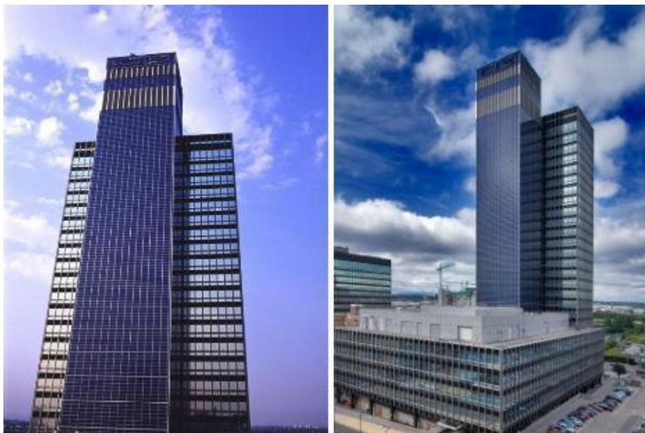
位于英国曼彻斯特的 CIS 太阳能大厦（CIS Solar Tower）是世界 14 座超级太阳能大厦之一。据了解，这座大楼是在拥有 40 多年历史的原有大楼基础上翻新而成的，最突出的亮点在于它所拥有的欧洲最大垂直太阳板阵列——大楼外部装有 7000 余块太阳能板。
