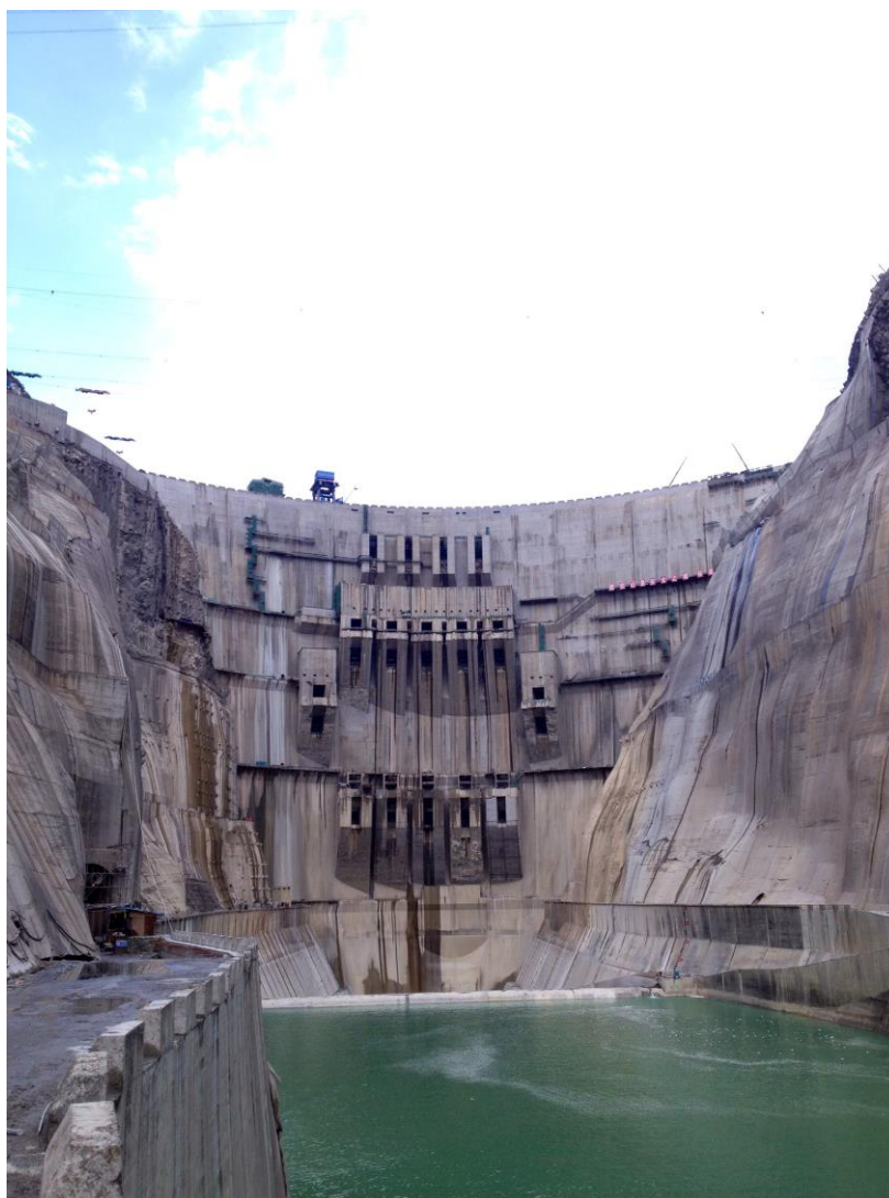
锦屏一级水电站大坝（下游面）
