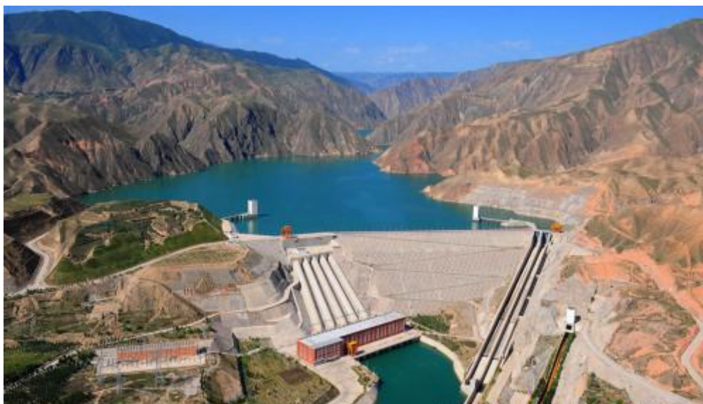
中电投龙羊峡水电站
