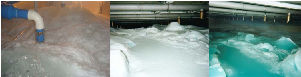
图 1-4 冰浆在蓄冰槽内的实际堆积情况
