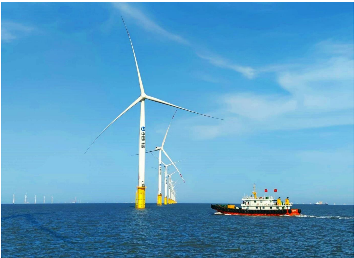
三峡能源江苏如东海上风电项目-国内首个柔直海上风电项目-胡德芳
