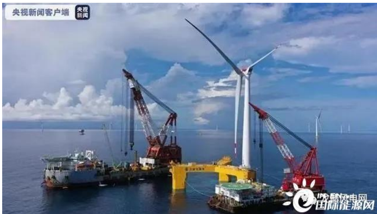
图片漂浮式机组安装现场
