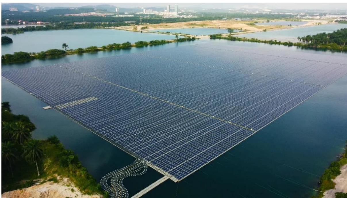
马来西亚 13MW 水面漂浮电站
