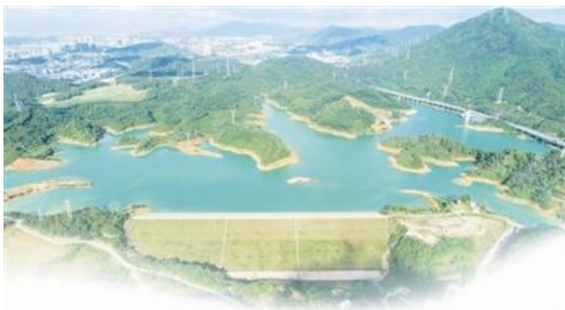
深圳抽水蓄能电站下水库。 深蓄电站/供图
