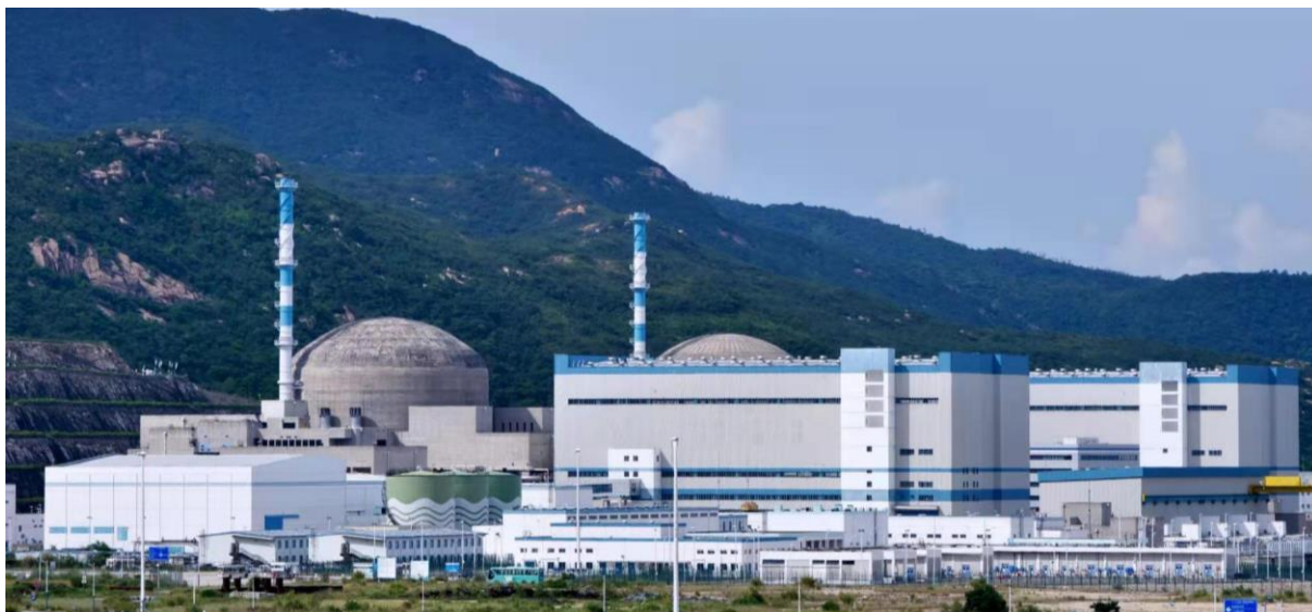
台山核电一期工程（前方为 2 号机组）
