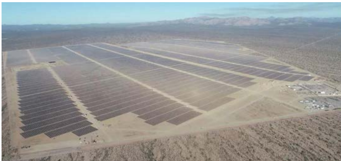
墨西哥利伯塔德港太阳能电站
