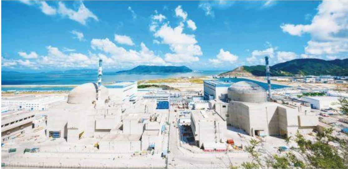
广东台山核电站规划建设 6 台核电机组，一期引进 EPR（欧洲先进压水堆）技术，建设 2 台单机容量为 175 万千瓦的核电机组。2018 年 6 月 29 日 1 号机组并网，成为全球首台并网发电的 EPR 三代核电机组。浙江三门核电站在全球率先采用第三代先进压水堆（AP1000）技术，一期建设 2 台 AP1000 机组，2018 年 6 月 30 日 1 号机组首次并网，成为全球首台并网发电的 AP1000 三代核电机组。两者均为世界首堆。
