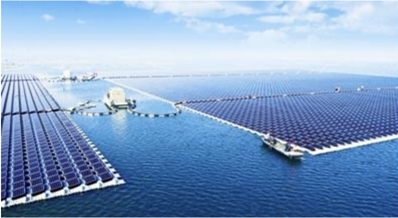
阳光电源建设的安徽淮南潘集水面漂浮式光伏发电项目，是全球单体最大的水面漂浮光伏电站。
