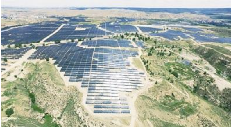
2015年6月，首个国家先进技术光伏示范基地落户大同采煤沉陷区。
