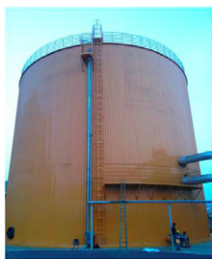
图 2 水蓄冷罐竣工外观图
