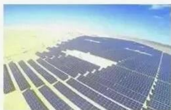
光伏发电项目
