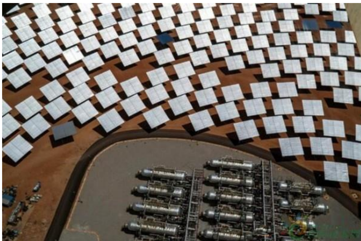
图：Khi Solar One 庞大的定日镜和水蒸气储热系统
